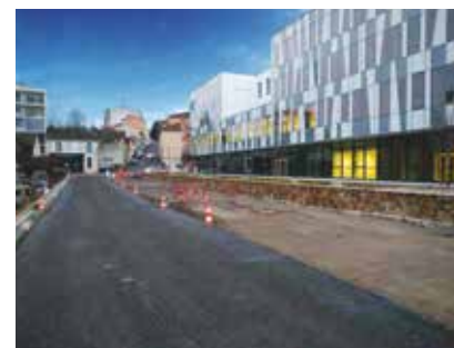
Voie nouvelle des Casseaux, livraison en mars 2024.
