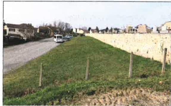
Mur sud du cimetière existant
