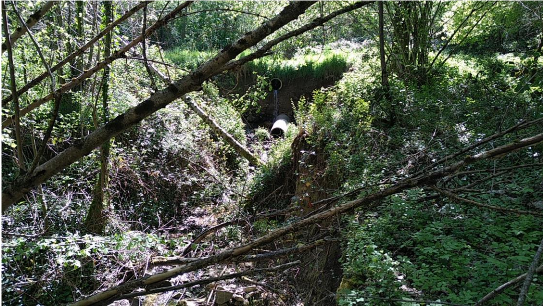
Etat du site après les fortes pluies
