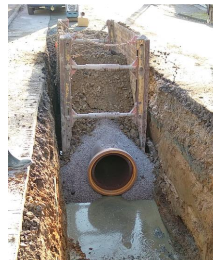
Réhabilitation du collecteur unitaire en matériau durable (grès) Rue Gustave Courbet - Limoges
