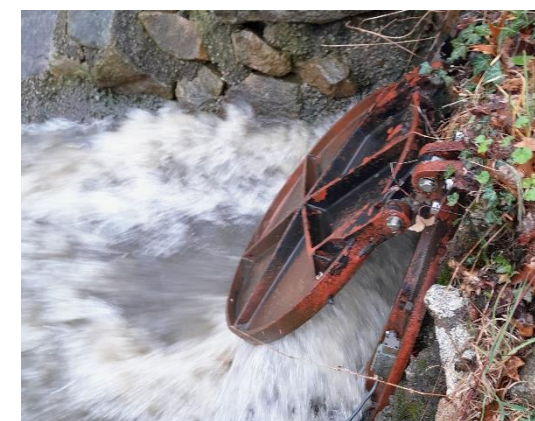
Déversoir clapet – Moulin Blanc
