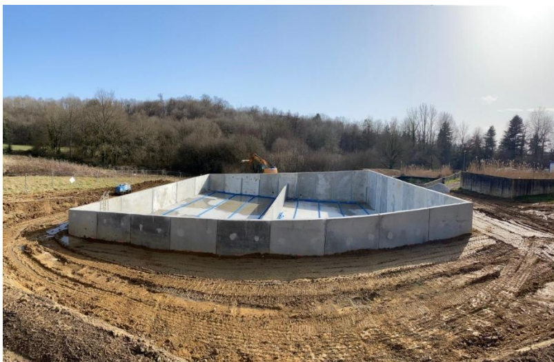
Travaux de réhabilitation de la station d'épuration du Roseau à Boisseuil
