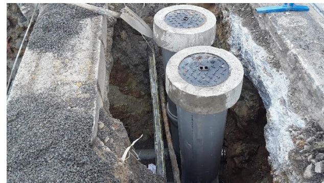
Branchement séparatif EU / EP Lotissement des 4 Vents à Boisseuil
