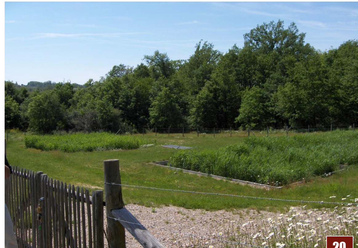
Station d'épuration par filtres plantés de roseaux – La Grange de Boeuil à Veyrac
