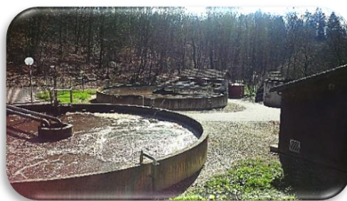
Station d'épuration de Balandie-Lespinasse
