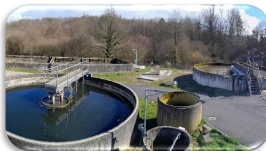
Station d'épuration du Roseau
