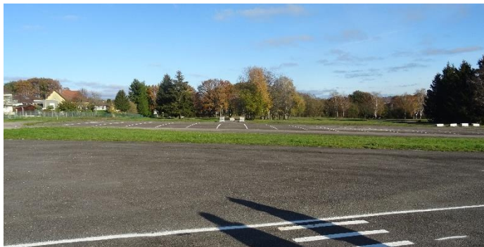
Grandes plateformes imperméabilisées du site Limoges Métropole - 2022
