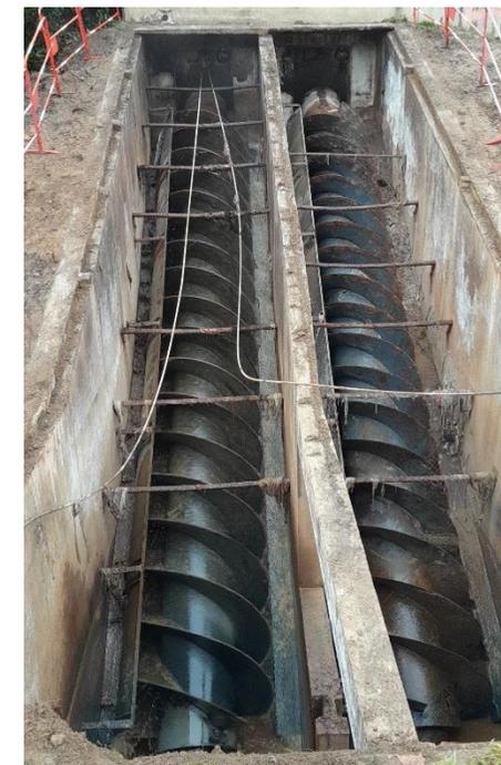
Vis de relevage du Pont St-Etienne - Limoges
