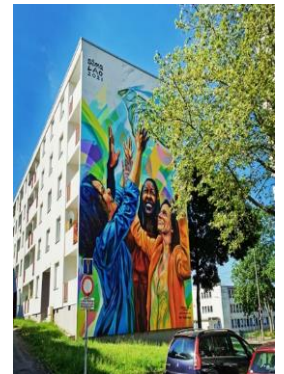
Façade – Immeuble N°11 à N°17
