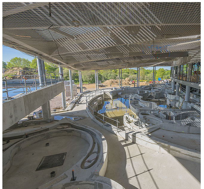
Construction du bassin olympique en 2014
